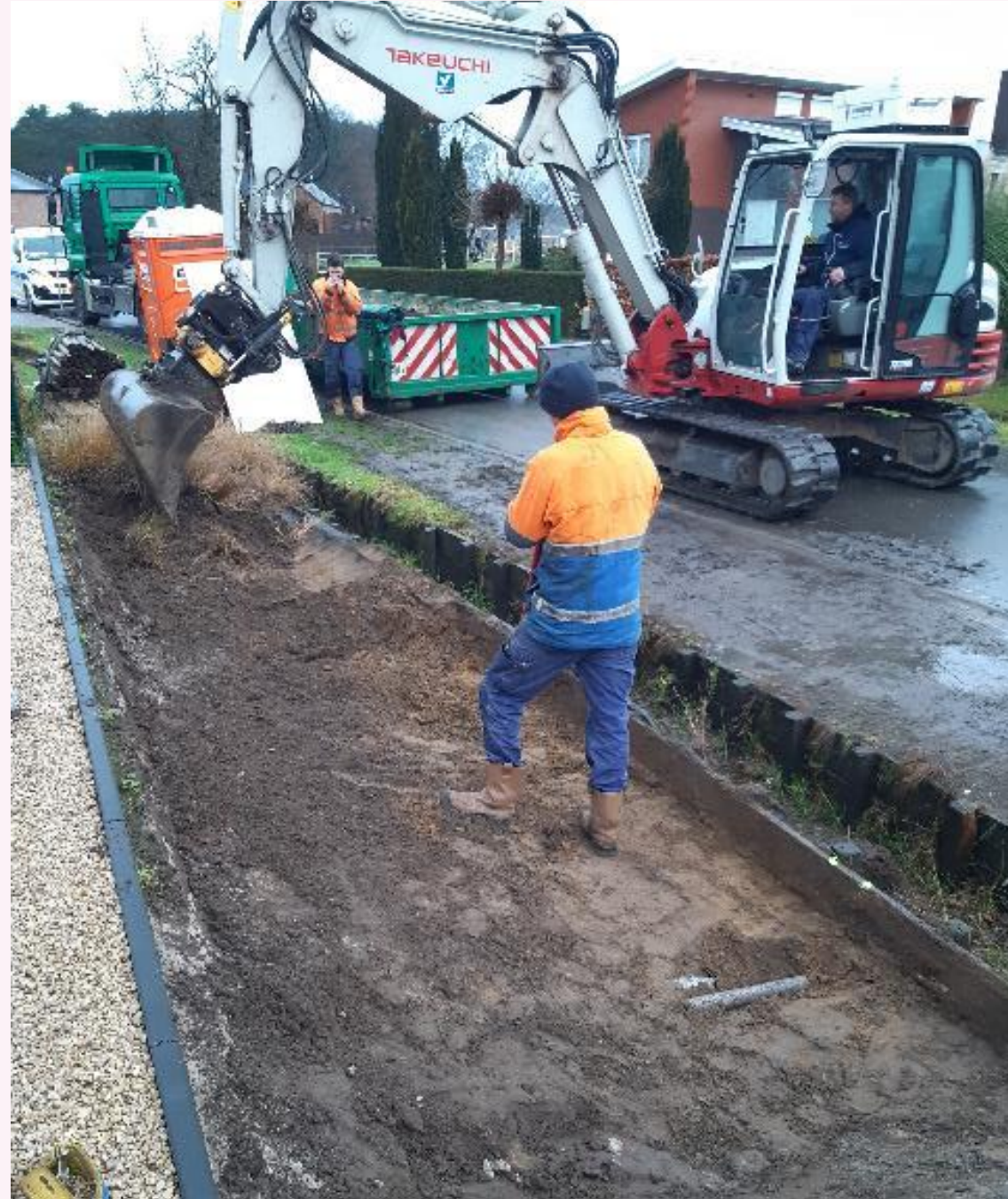
Ontgraving verontreinigde zone
