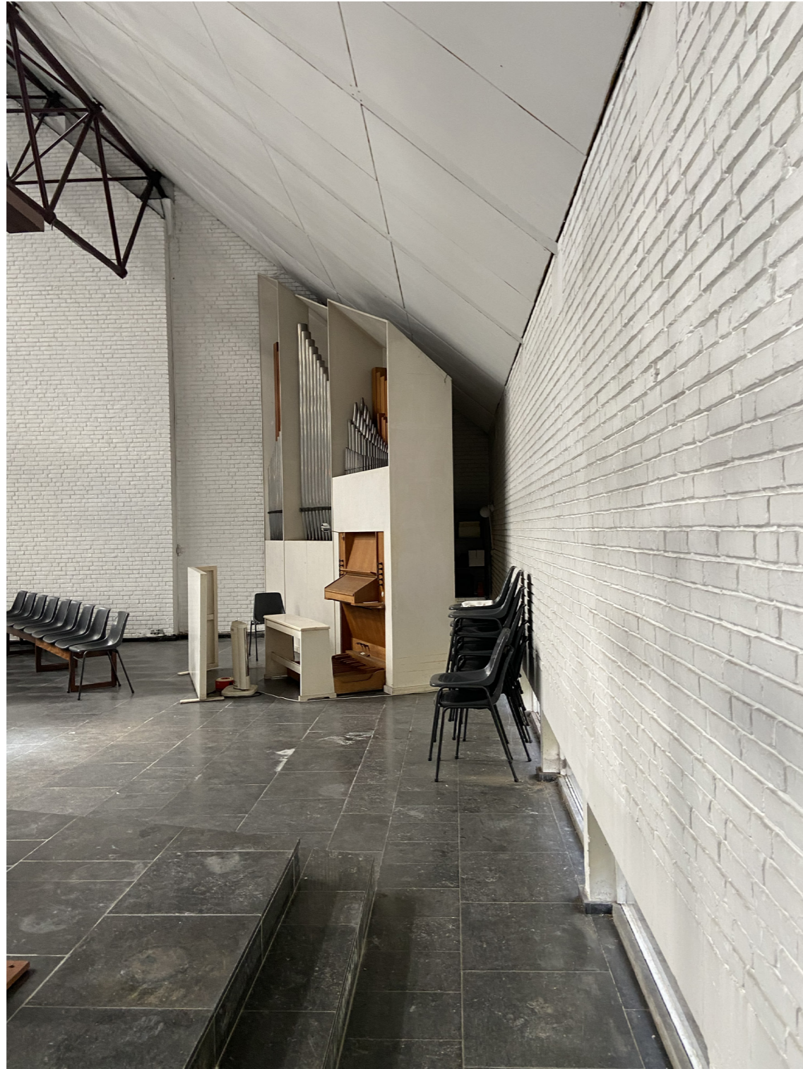
foto's kerkzaal (2023) - kenmerkende dakstructuur
