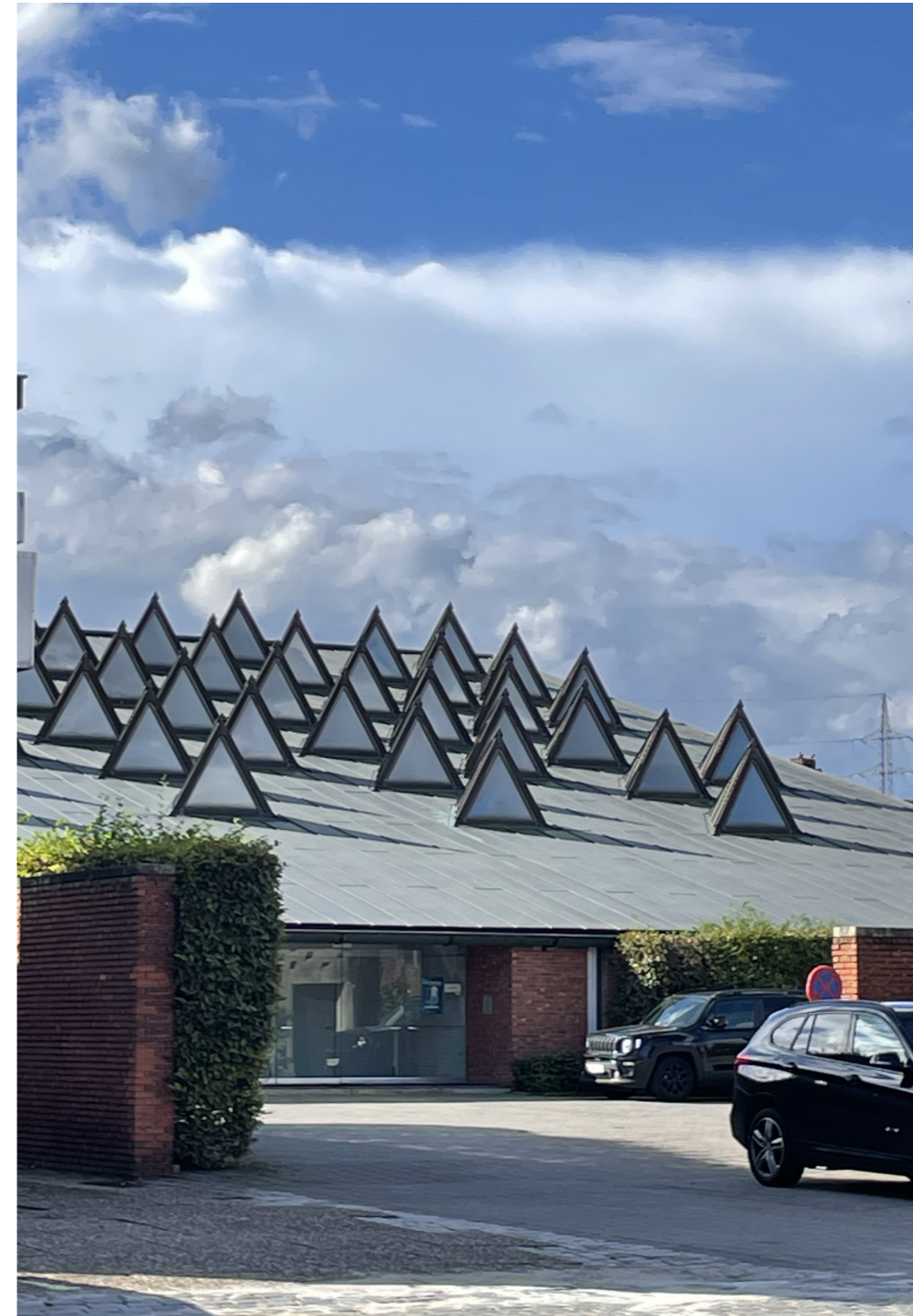
Zicht op hoofdtoegang van de kerk
