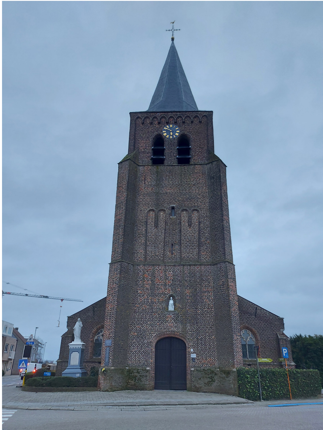
Zicht op de toren en inkom vanop de parkeerplekken aan de overkant.
