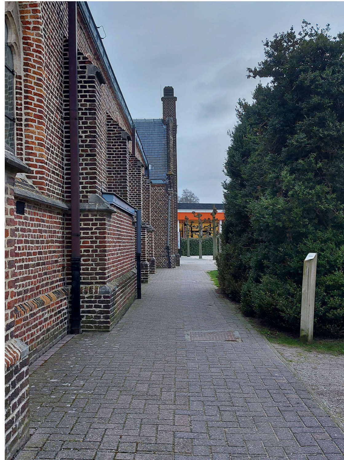
langspad langs zuidgevel kerk
