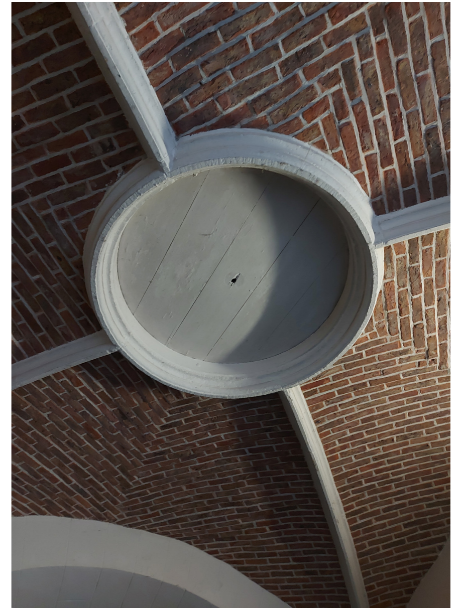
kruisgewelf van vestibule met een gat om voorwerpen naar het orgel te hijsen
