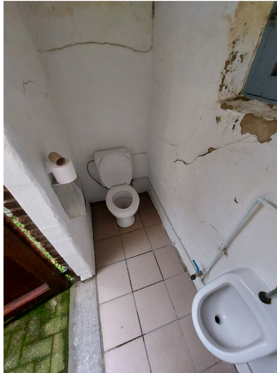
sanitair aan buitenruimte
