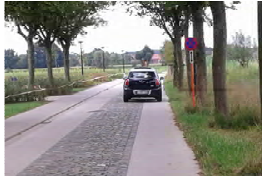
Figuur 13: Goed voorbeeld van toepassing van een kasseistrook in Hove.
