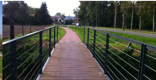
Figuur 4: Mooi vormgegeven infrastructuur voor fietsers draagt bij aan de aantrekkelijkheid van een route. Fietsbrug parallel aan de rijbaan voor auto's. Zoutleeuw.
