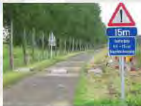
Aandacht gaat in dit vb. uit naar een correct uitgevoerde afstandregeling.
