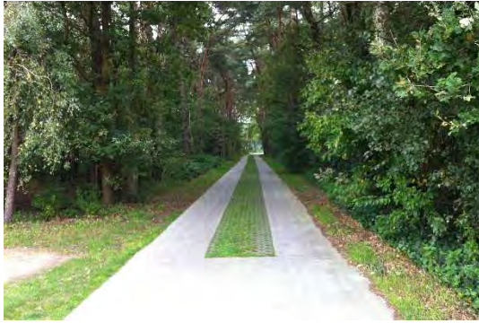
Figuur 12: Goed voorbeeld van een dubbele rijloper of karrespoor. De grasbetonstenen in het midden vormen een goed verharde strook voor fietsers die moeten uitwijken.
