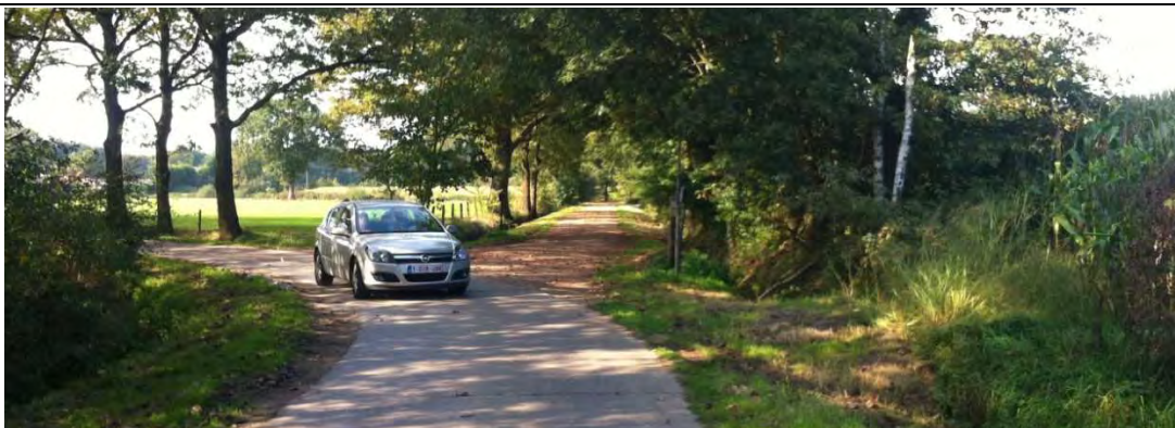
Figuur 5: Goed voorbeeld van een plattelandsweg in Meerhout met een smal profiel. Autoverkeer wordt gestimuleerd om de weg naar links te volgen door verschil in materiaal en uiterlijk, maar het is wel mogelijk om rechtdoor te rijden.
