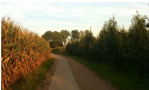
Figuur 10: Goed voorbeeld (omgeving Zoutleeuw) van een smal profiel voor fietsers en een fietsvriendelijke verharde berm die ook gebruikt kan worden door landbouwverkeer. De rijloper voor fietsers is voor hoge fietsintensiteiten eigenlijk te smal: fietsers kunnen elkaar alleen passeren als ze achter elkaar fietsen. Dergelijke bermverharding kan worden toegepast als landbouw verkeer er zeer incidenteel gebruik van maakt en eventuele bermshade (bijvoorbeeld putten) regelmatig worden hersteld.
