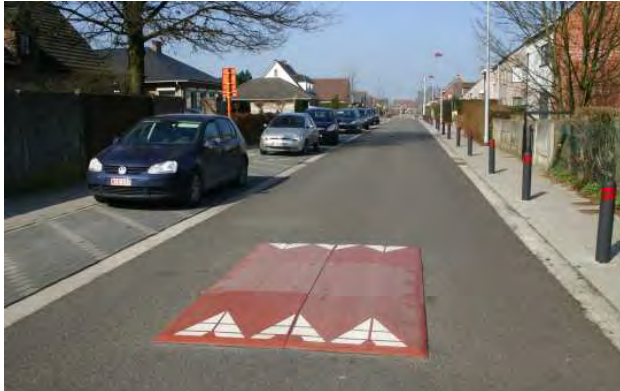
Figuur 14: Goed voorbeeld van een rijbaankussen met voldoende ruimte om te passeren als fietser (foto: intercodam)
