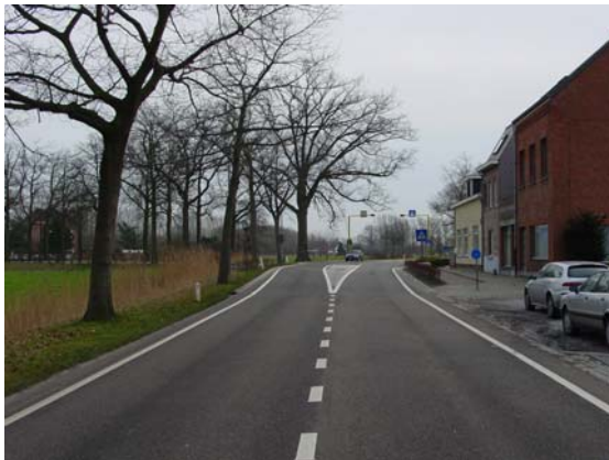
Foto N124, aansluiting met Hoefijzer – Lindendreef (komende vanuit het centrum)
