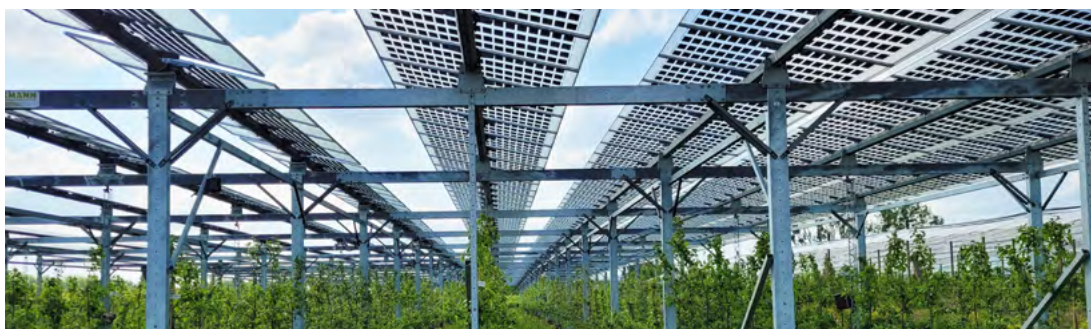
Zonnepanelen boven gewasrijen leveren energie én beschermen de teelt. - foto: Omexom
