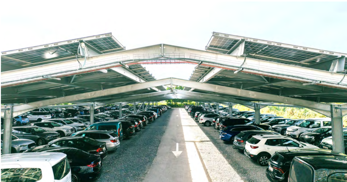
PV-carportconstructie boven parkeerterrein. - foto: Omexom
