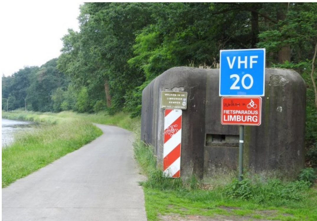
Illustratie 11.14: Betonnen bunker aan de zuidzijde Kanaal Bocholt-Herentals op de grens tussen Mol en Lommel
